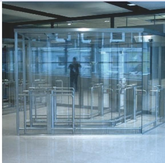
Полностью стеклянное исполнение шлюза в форме коридора с функцией прохода в одном направлении и угловой конструкцией для защиты от перебрасывания
